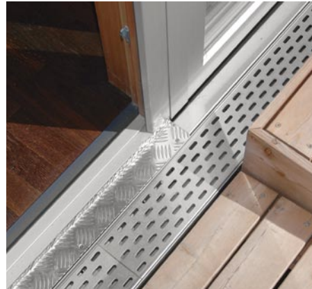
Holzbau nach Mass: Für das Parkett in den Büros wurde Eiche, für den Terrassenboden sibirische Lärche verwendet.
